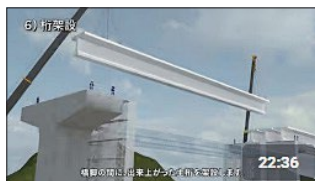
PC橋架設工
